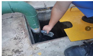
⑧ 收集废水外送处 理，经处理后检测合 格排放
